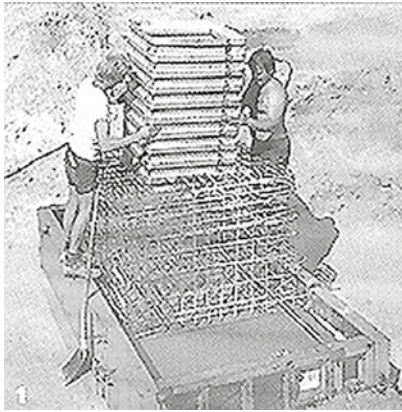
1. Die Bewehrung ist eingebaut. Der Schalungsköcher steht zum Einbau bereit. Die Fundamentplatte ist frisch betoniert. Der Köcher wird in die Bewehrung eingeführt
